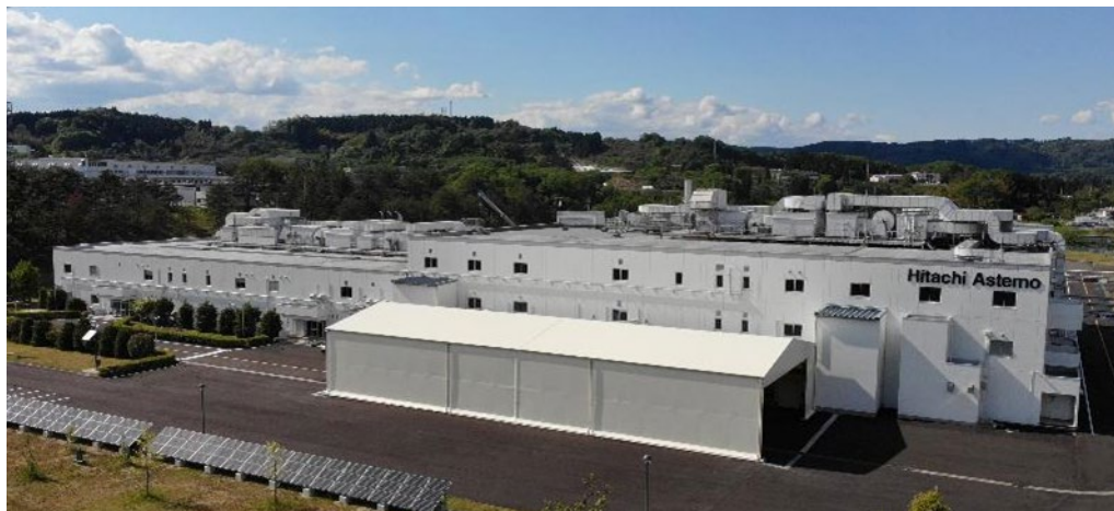
宮城第四工場外観
